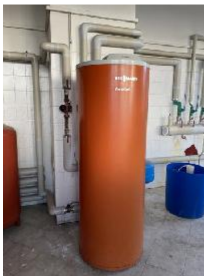
Zdj. nr 15 i 16. Ogrzewanie hal garażowych rurami grzewczymi położonymi w kanałach w posadzce. Ciepła woda użytkowa przygotowywana w podgrzewaczu pojemnościowym 350 dm 3 przez dwa kotły gazowe z końca lat 90-tych XX wieku.
