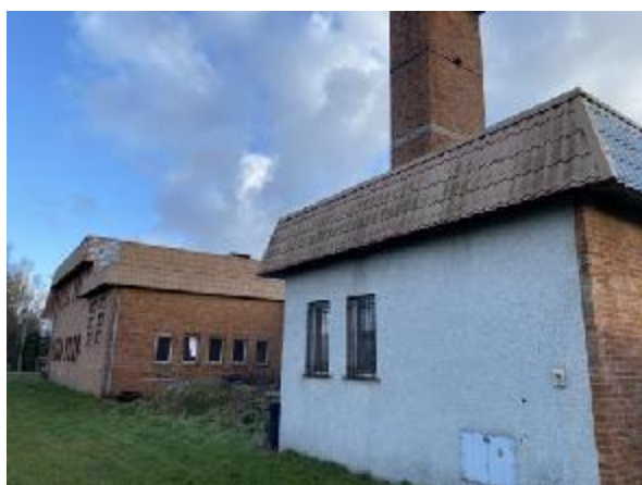
Zdj. nr 9 i 10. Elewacja tylna i boczna budynku magazynowo -garażowego Komendy Powiatowej PSP w Kołobrzegu. Stolarka okienna drewniana dwuszybowa, w bardzo złym stanie technicznym.
