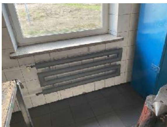
Zdj. nr 13 i 14. Rury instalacji grzewczej stalowe, spawane, położone przy ścianach zewnętrznych, zasilają z boku grzejniki stalowe, płytowe oraz rurowe z zaworami i głowicami termostatycznymi.
