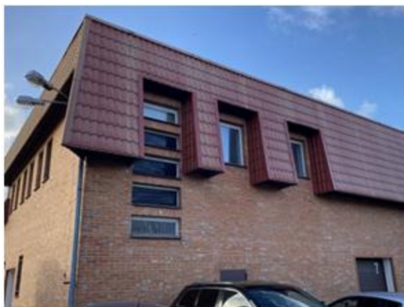
Zdj. nr 9 i 10. Elewacja tylna i boczna budynku magazynowo -garażowego Komendy Powiatowej PSP w Kołobrzegu. Stolarka okienna drewniana dwuszybowa, w bardzo złym stanie technicznym.
