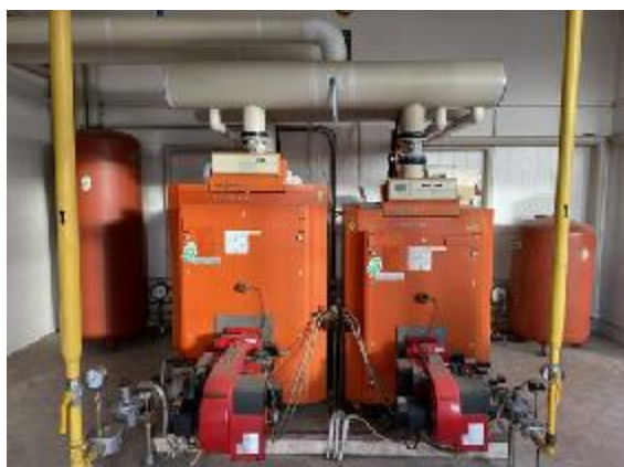
Zdj. nr 17 i 18. Instalacja c.o. zasilana w ciepło z kotłowni gazowej zlokalizowanej w budynku garażowo-magazynowym. Technologia kotłowni i dwa kotły gazowe z końca lat 90-tych XX wieku. Kotły zasilane gazem ziemnym zaazotowanym GZ-35 o mocy 225 i 405 kW. Razem moc zainstalowana
