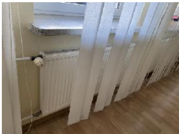
Zdj. nr 13 i 14. Rury instalacji grzewczej stalowe, spawane, położone przy ścianach zewnętrznych, zasilają z boku grzejniki stalowe, płytowe oraz rurowe z zaworami i głowicami termostatycznymi.
