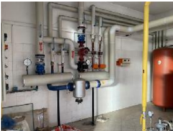
Zdj. nr 17 i 18. Instalacja c.o. zasilana w ciepło z kotłowni gazowej zlokalizowanej w budynku garażowo-magazynowym. Technologia kotłowni i dwa kotły gazowe z końca lat 90-tych XX wieku. Kotły zasilane gazem ziemnym zaazotowanym GZ-35 o mocy 225 i 405 kW. Razem moc zainstalowana
