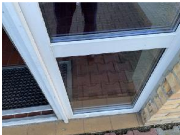
Zdj. nr 11 i 12. Stolarka okienna i drzwiowa w budynku głównym administracyjno-garażowo-warsztatowym na profilach PCV z przeszkleniem zespolonym dwuszybowa z 2005 roku. Natomiast w budynku garażowo-magazynowym w stolarka okienna w większości drewniana, dwuszybowa z 1998 roku w bardzo złym stanie technicznym.
